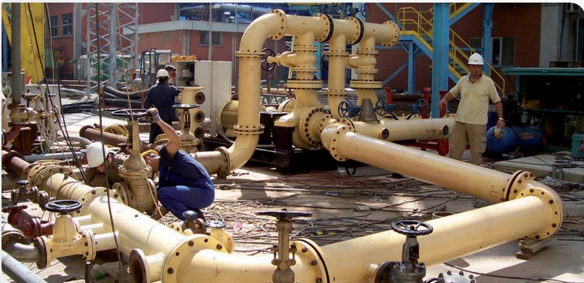
► Queste attività sono finalizzate all'eliminazione di depositi, incrostazioni ed ossidazioni presenti sulle superfici metalliche interne delle apparecchiature e dei circuiti degli impianti industriali. L'obiettivo principale è quello di ripristinare lo scambio termico e/o di passivare la superficie metallica, al fine di preservarla da possibili corrosioni.
